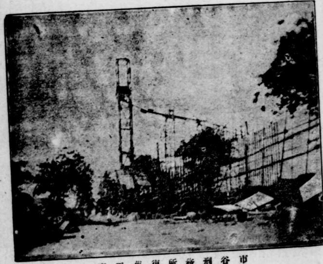
市谷刑務所復舊工事
